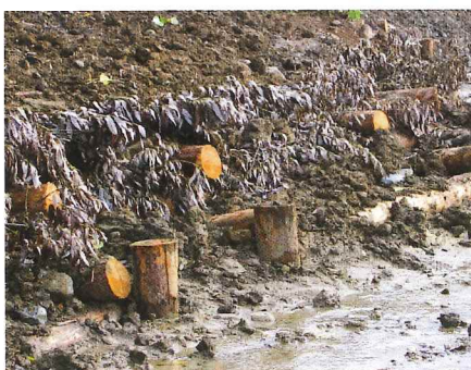
Abb. 2: Ingenieurbiologische Maßnahme mit Weiden (Gattung Salix) zur Stabilisierung des Flussuferbereichs im Zuge einer Rekultivierungsmaßnahme.
