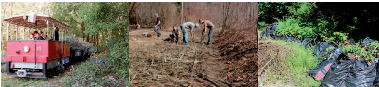
Pflegeeinsätze im Europaschutzgebiet: Schwenden und Materialabtransport (links), Bau einer Weidenspreitanlage (Mitte) und die Entsorgung großer Mengen an Neophyten (rechts).
