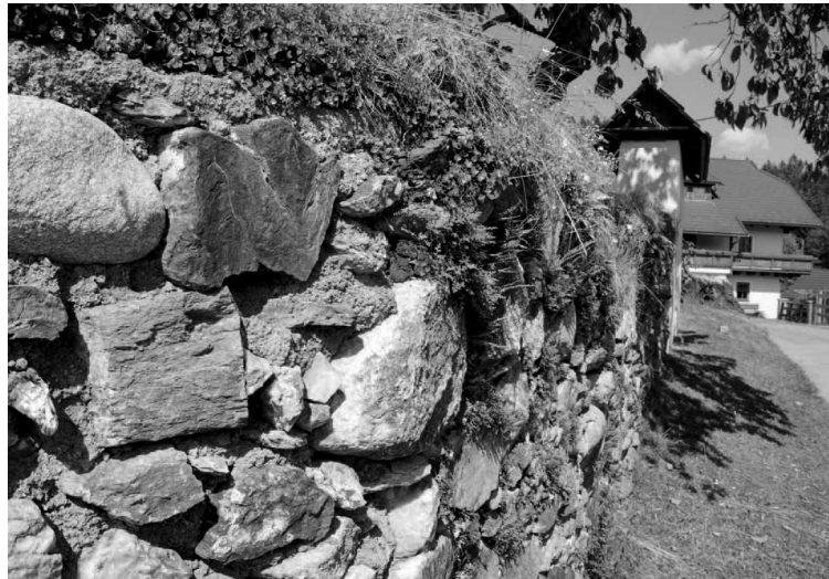
Abb. 4: Trockensteinmauer in Wöllan/Arriach. Foto: H. Kirchmeir
